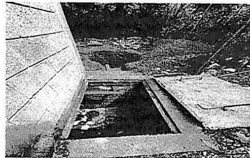
Foto 6: Trabajando el area de drenaje y tuberias.
