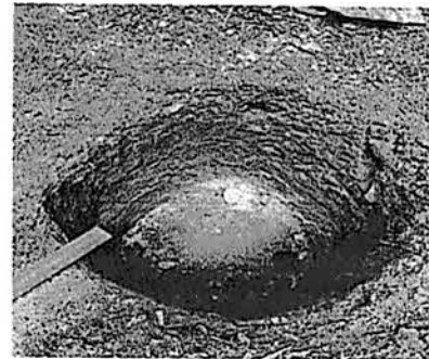
Foto 4: Realizacion de fosa septica.
