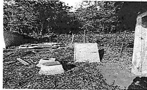
Foto 2: Desinstalacion de letrinas
